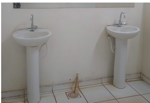
Figura 12 - Lavatórios de coluna a serem substituídos.
