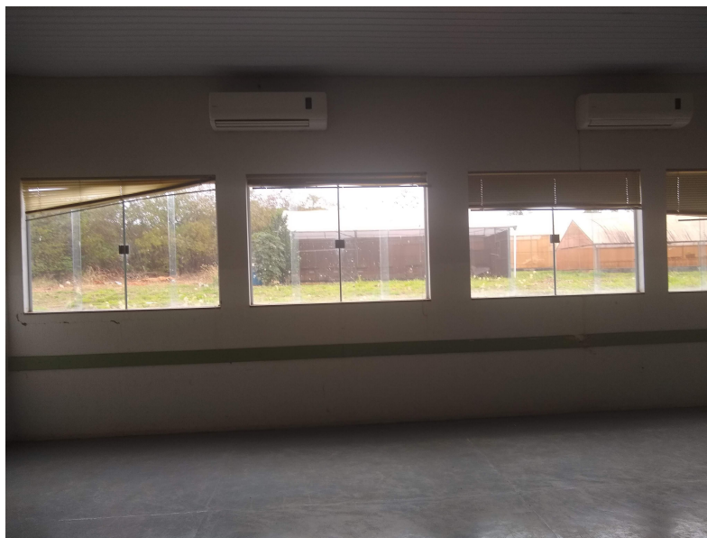
Figura 7 - Janelas Sala de Aula.
