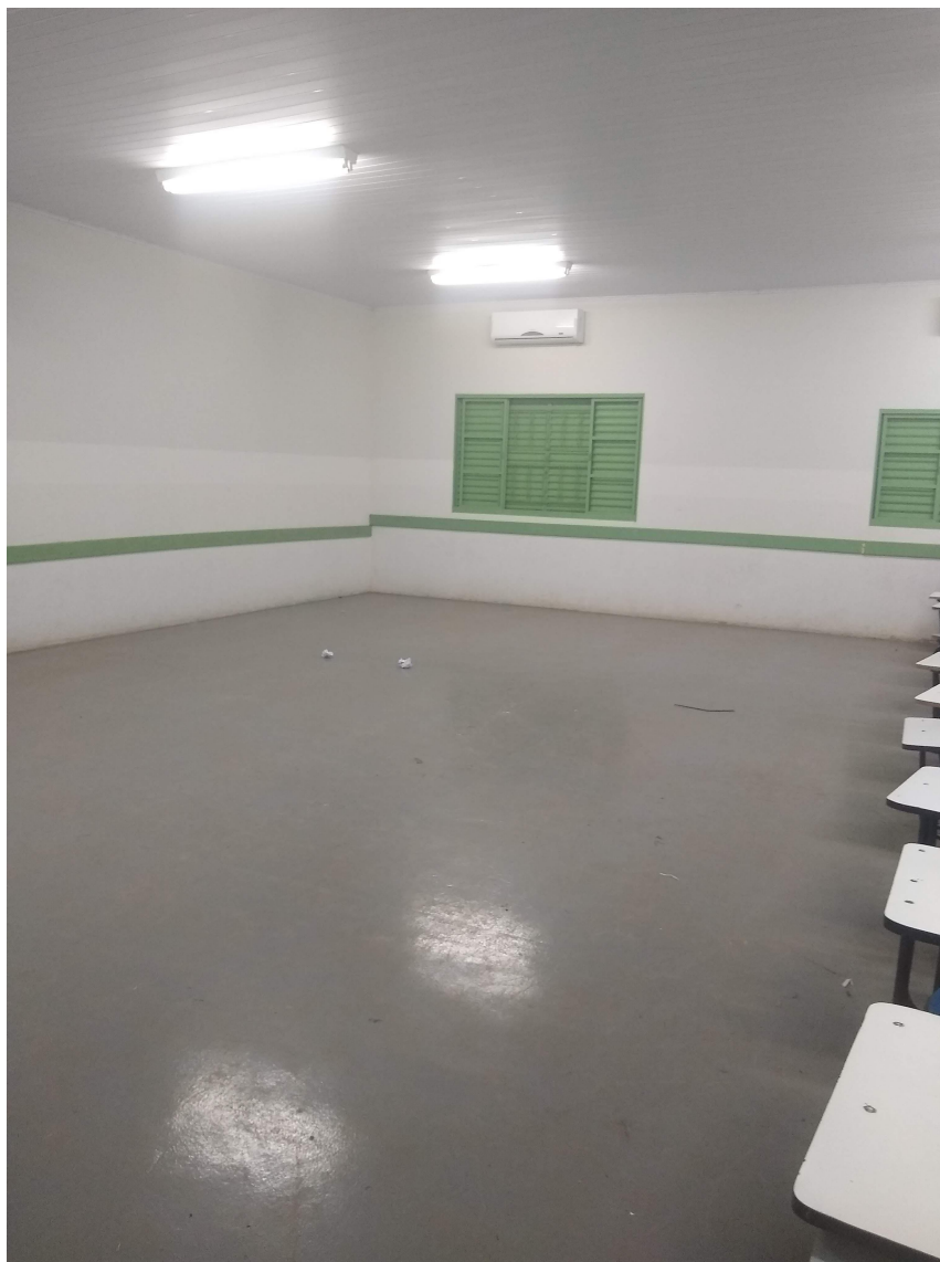
Figura 15 - Sala de Aula com janelas a serem substituídas e pintura a ser executada.
