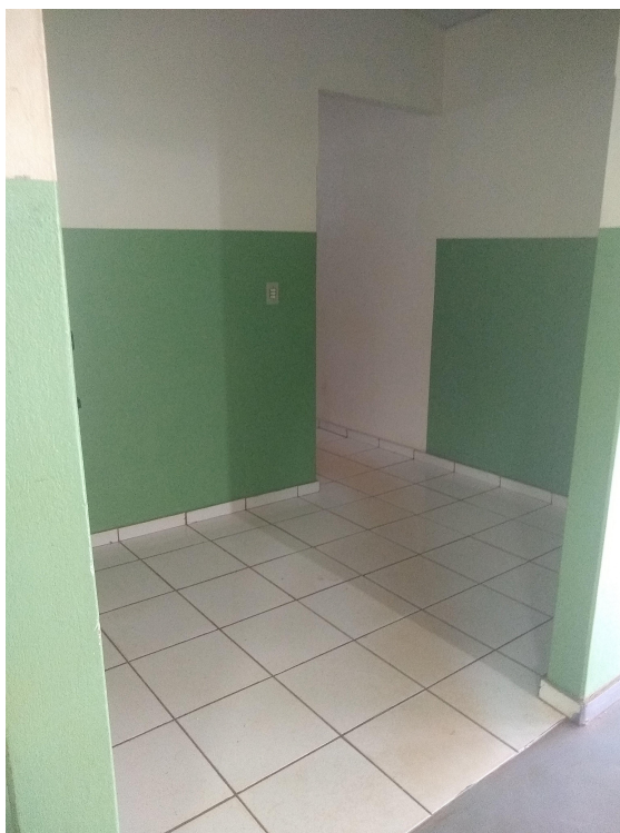
Figura 11 - Entrada banheiro da Área de Vivência II.
