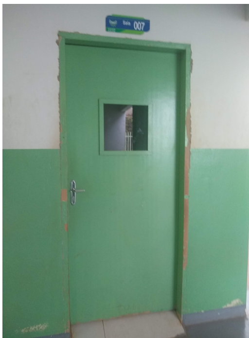
Figura 16 - Portas a serem substituídas por portas metálicas.
