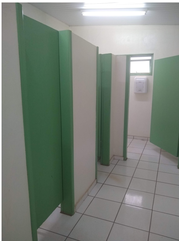
Figura 13 - Banheiro Área de Vivência II.
