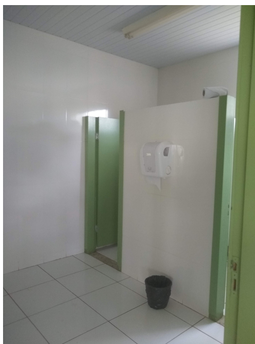
Figura 4 - Banheiros Área de Vivência I.
