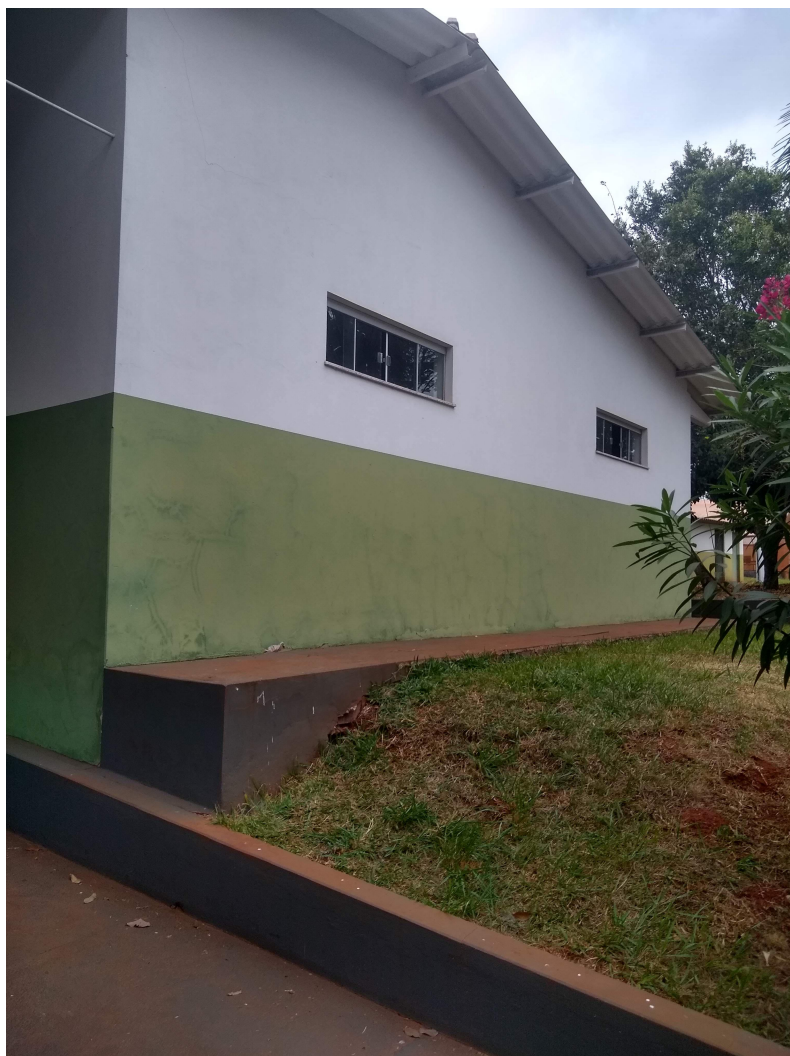
Figura 2 – Banheiros Área de Vivência I.
