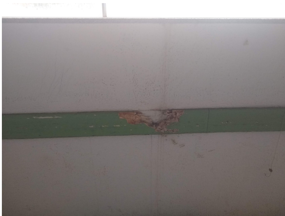
Figura 8 - Bate carteira a ser substituído.
