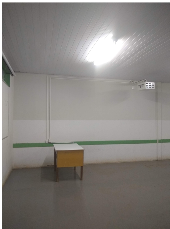
Figura 19 - Instalações elétricas a serem embutidas.
