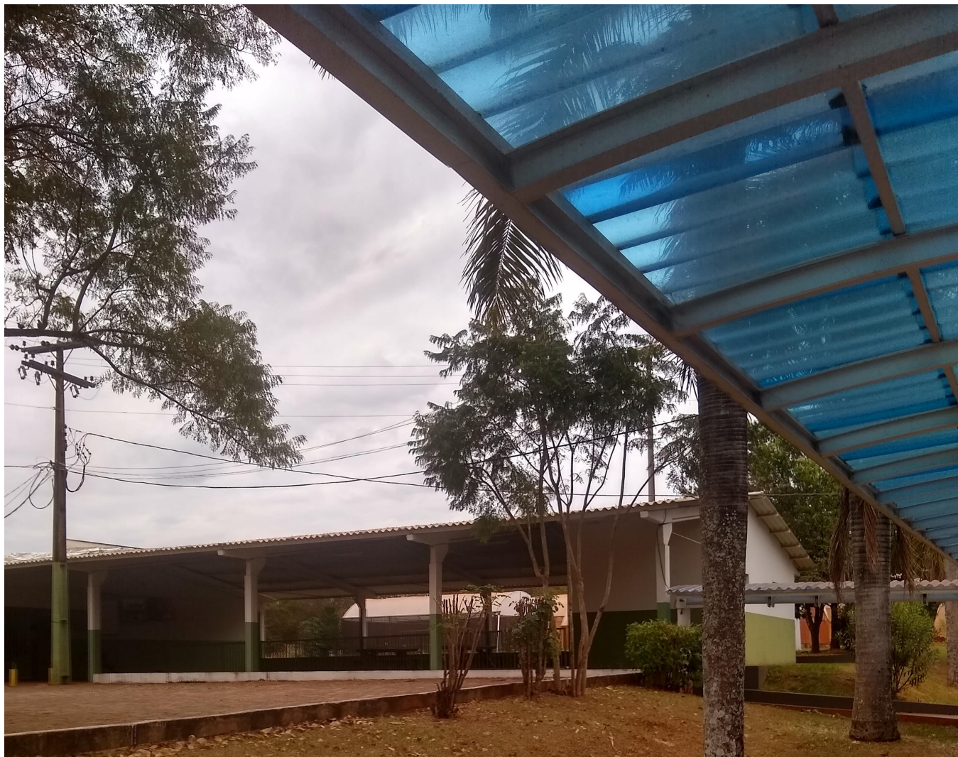
Figura 1 - Entrada do Bloco IV.
